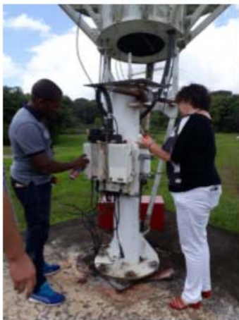
Limpieza componentes antenna
